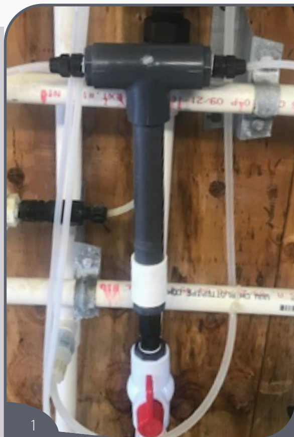
1 Дозатор, установленный в линии поения, ускоряет время реакции с диоксидом хлора
