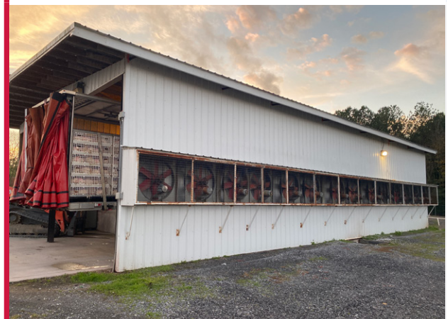
Εικόνα 4.6 Παράδειγμα κατάλληλων εγκαταστάσεων αναμονής στο εργοστάσιο μεταποίησης.
