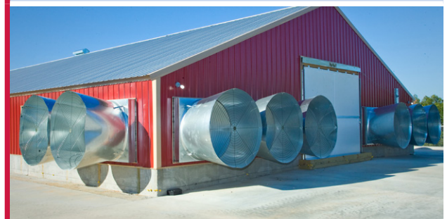
Εικόνα 6.17 Παράδειγμα τυπικού κτιρίου με αερισμό τούνελ.
