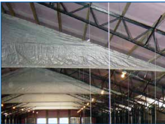
图 6.14: 空气第一个挡风板/挡风帘在纵向通风的鸡舍中的位置示例。
